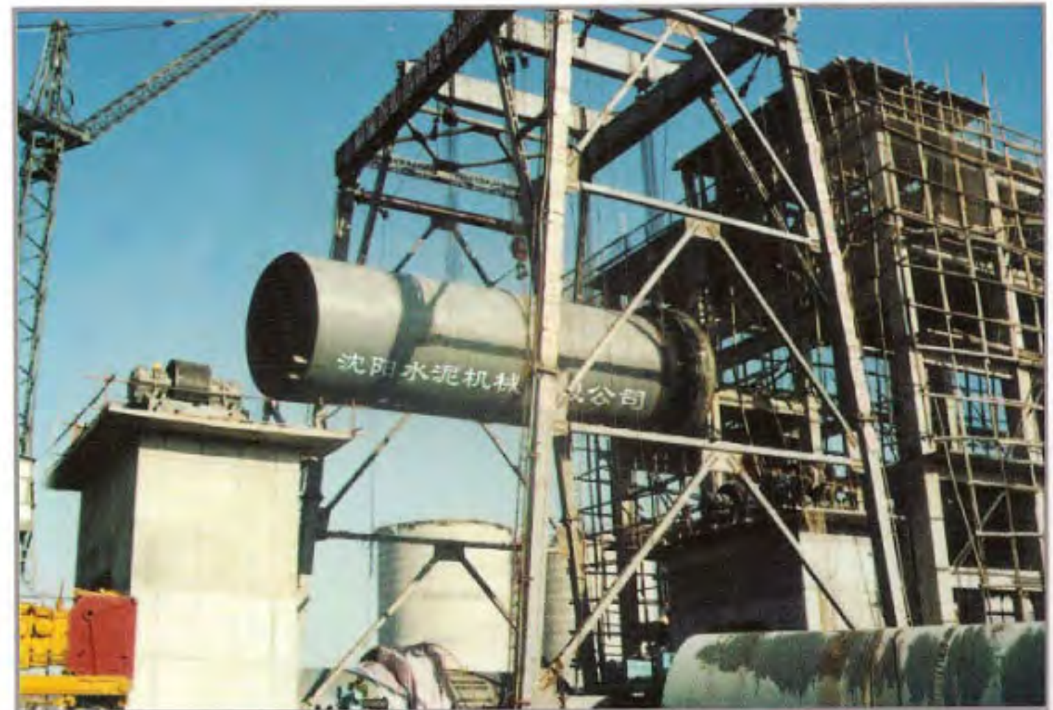
安装中的日产5000吨水泥生产线 5000tpd cement production line under installation
