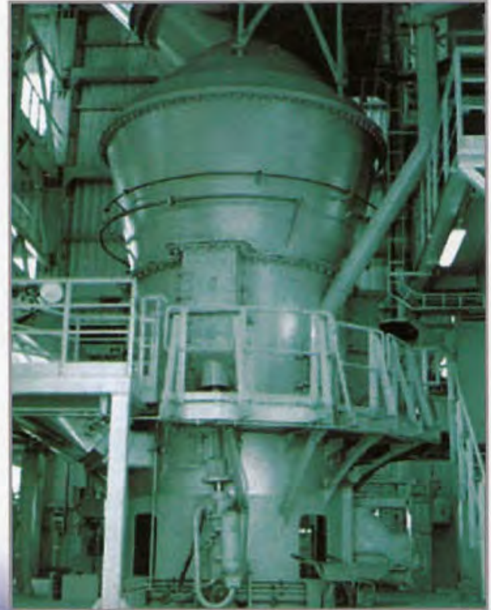
安装调试中的立式磨机 Vertical mill under commissioning
