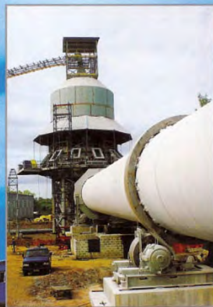
巴西MG活性石灰工程 Brazil MG lime project
