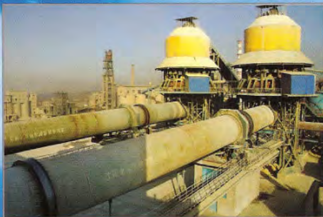
包钢活性石灰工程 Baotou steel lime project
