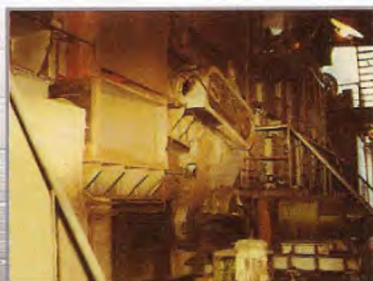
中国第一台篦冷机（辽阳小屯水泥厂） The first grate cooler in China
