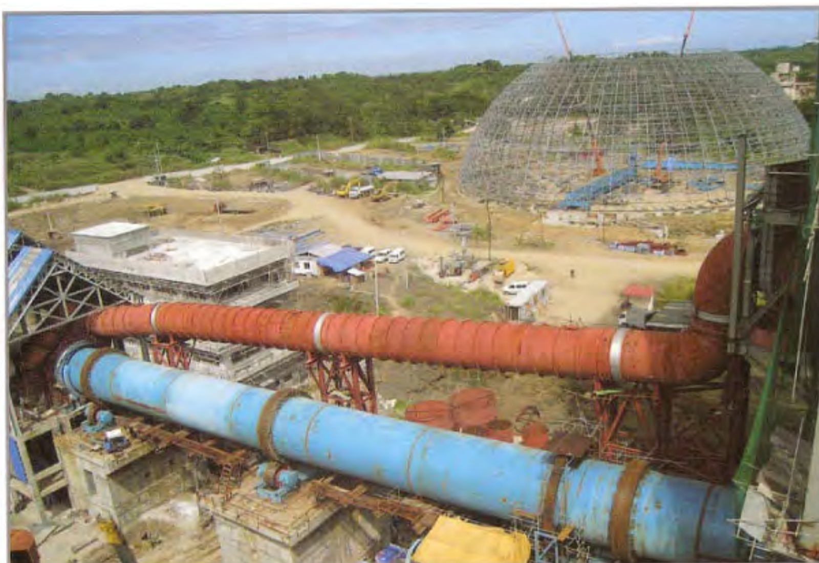
菲律宾老鹰水泥公司日产4000吨水泥生产 线全套主机由沈水机提供 Main equipments for 4000tpd exported to Philippines Eagle company
