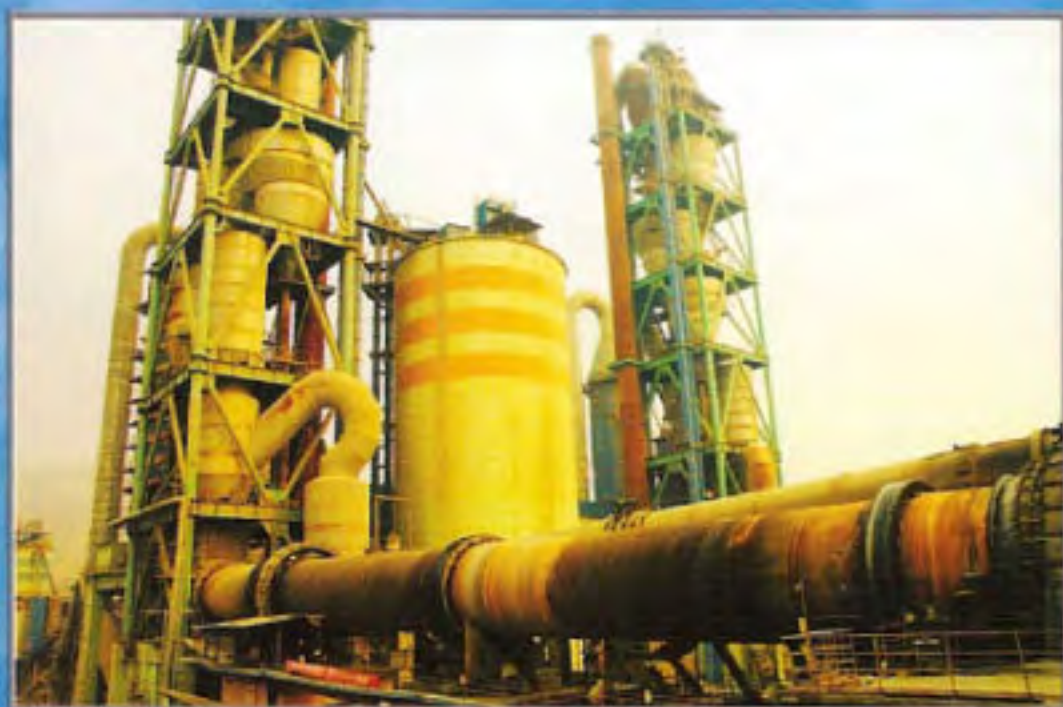
日产3400吨水泥生产线 3400tpd cement production line
