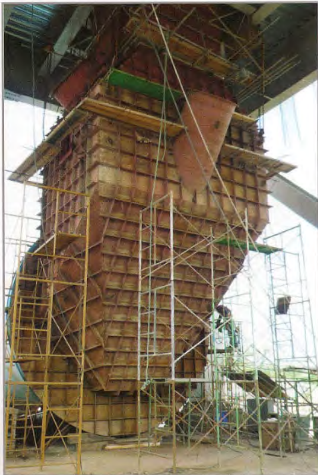
安装中的菲律宾4000tpd生产线 4000tpd production line under installation in Philippines
