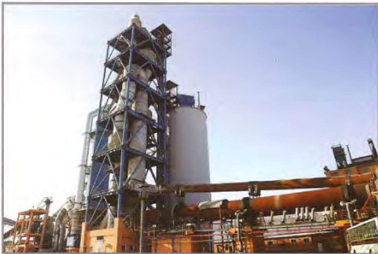
日产2500吨水泥生产线 2500tpd cement production line
