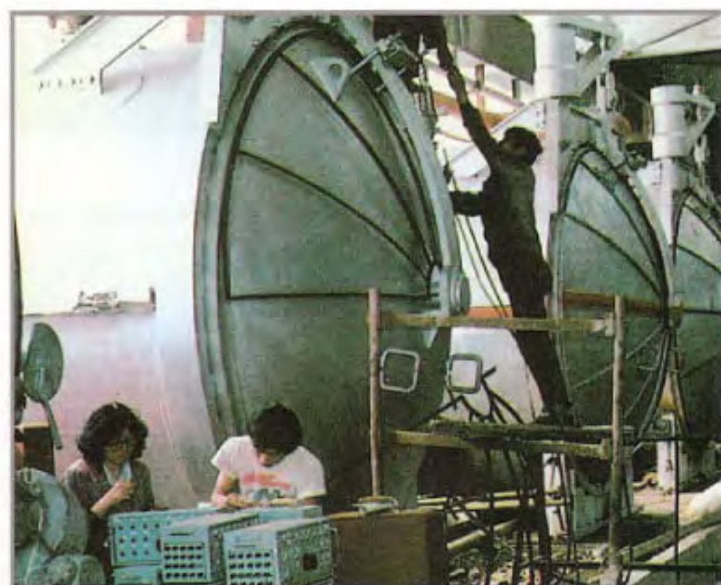
蒸压釜现场检测 Site inspection on autoclave
