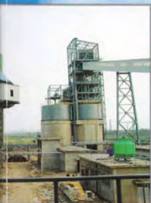
山西介休钢厂活性石灰工程 Shanxi Jiexiu steel lime project
